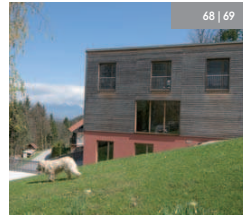
Kubus na pobočju | The Hillside Cubus
